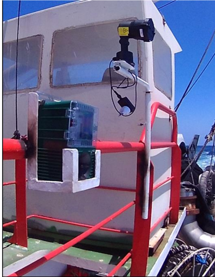
Figura 2: Equipos instalados en la cubierta de contra puente
